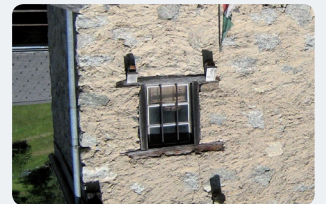
La petite dimension des fenêtres permet de limiter les pertes de chaleur
