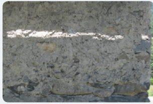
Les pierres sont liées et recouvertes par de la chaux
